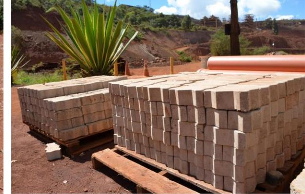
**Material empilhado a seco é usado na composição do solo e fabricação de blocos**
