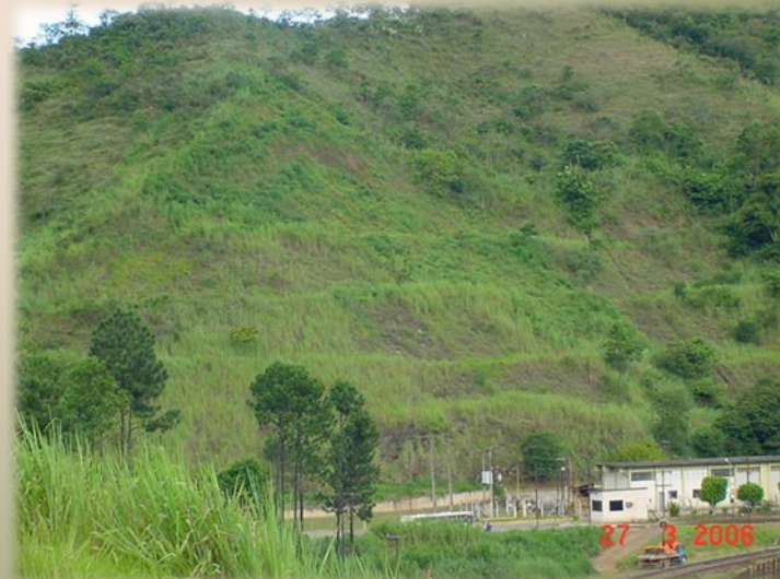
Implantação de leira com Bermalonga para redução da altura do talude Acerto manual para suavizar ângulos negativos 28 10:43 AM
