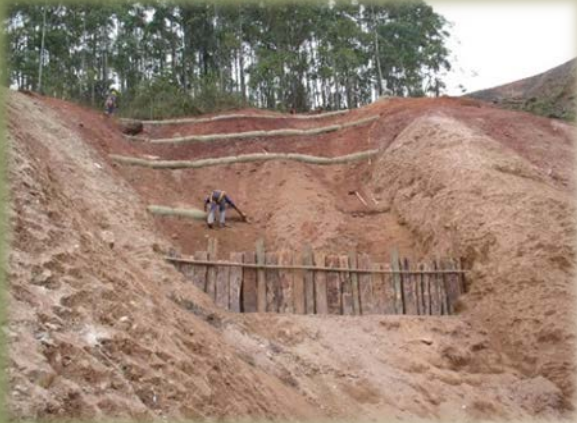
Paliçadas de Madeira
