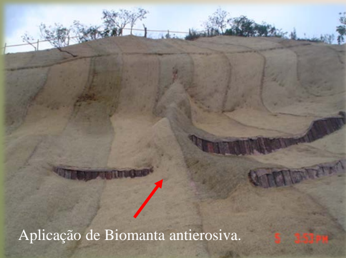
Construção de barramentos escalonados tipo Paliçada 19 11:35 AM
