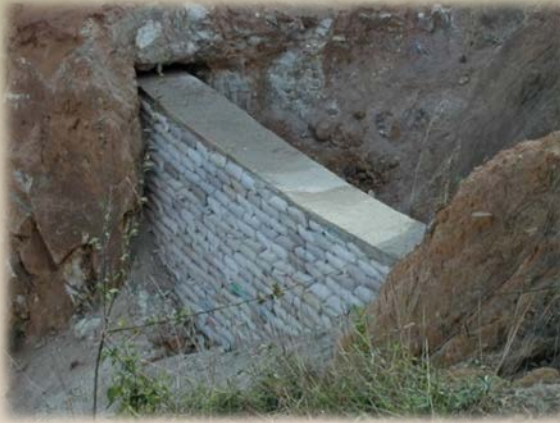
Rip-rap de saco solo: cimento
