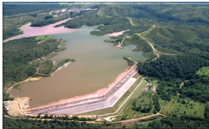
Barragem de Rejeitos
