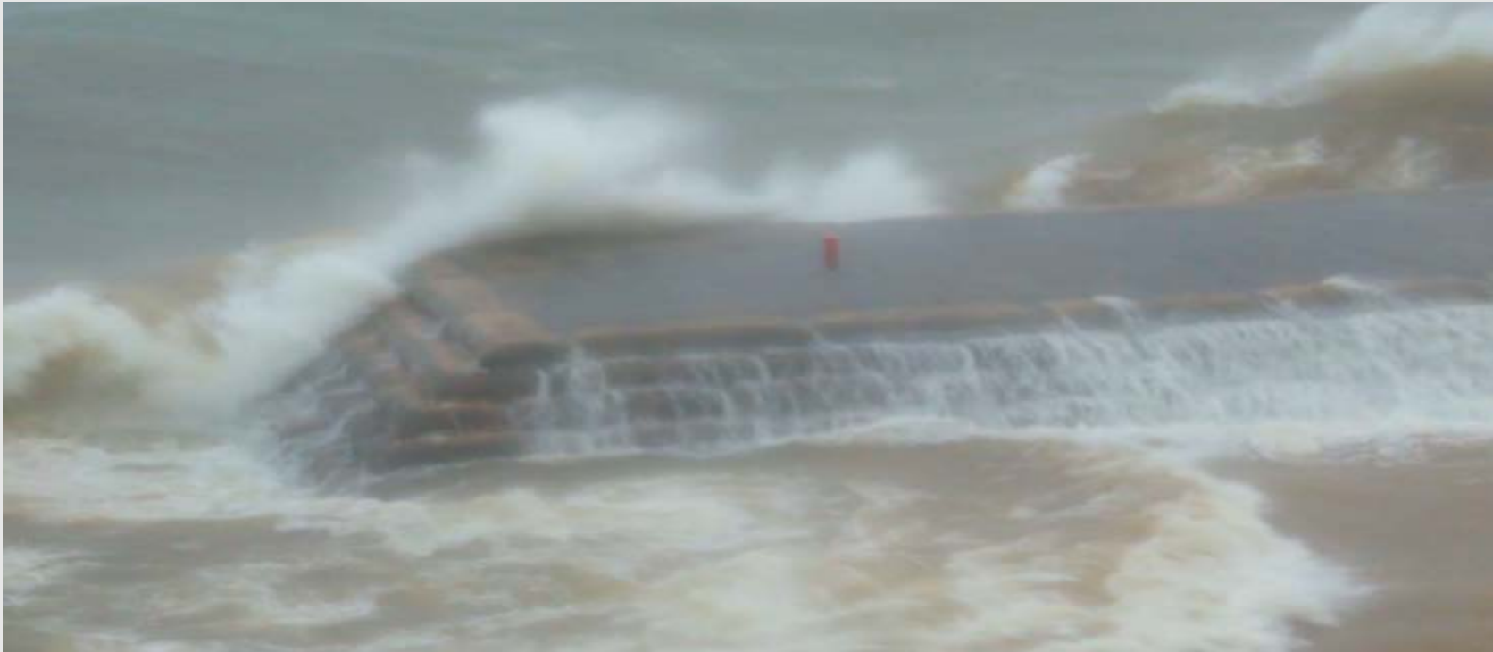
Quebra-Ondas e Ancoragem de Barcos do Porto da JOMANE - Presidente Epitácio - SP
