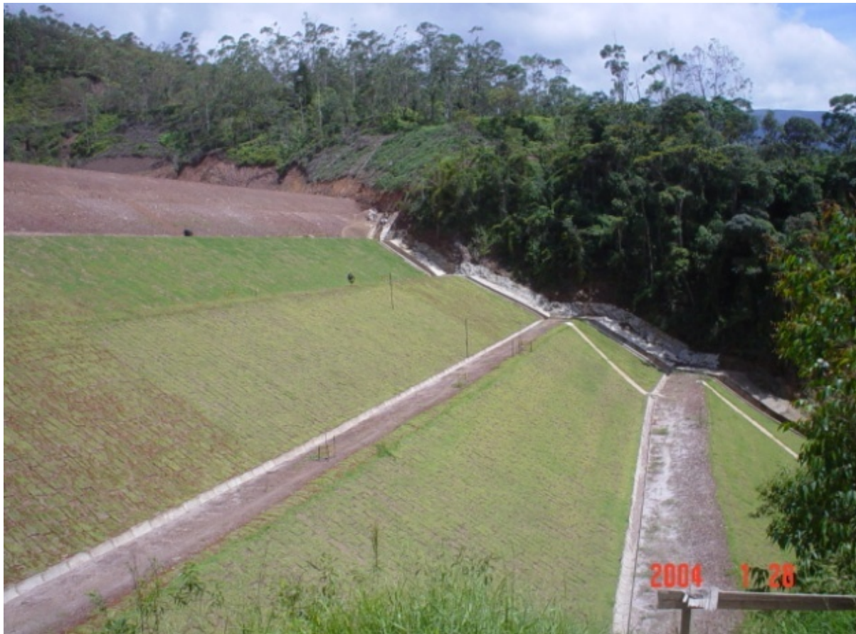
Vista do Talude Final com o Fechamento Progressivo
