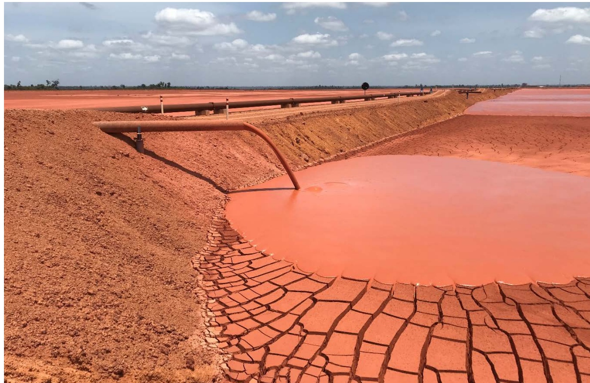
Lançamento de rejeitos
