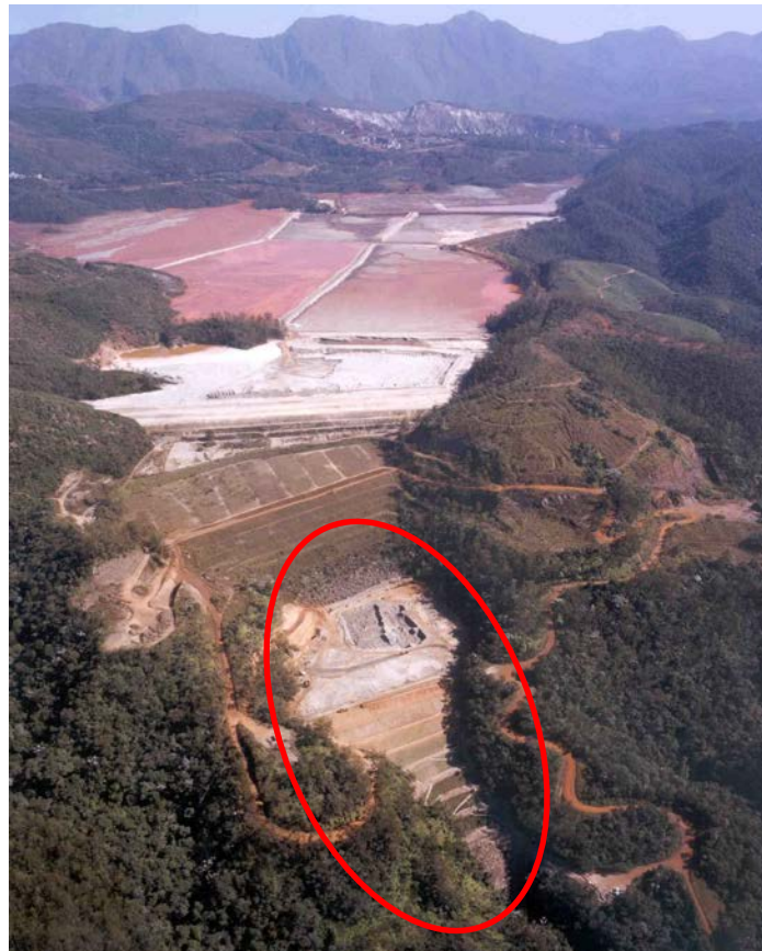
Vista Aérea da Pilha a Jusante da Barragem do Germano em estágio inicial de Construção – Germano Jusante
