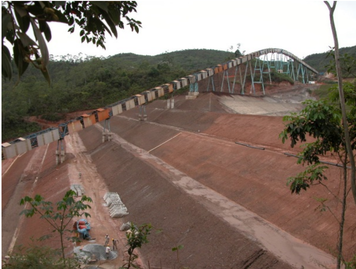
Vista da Estrutura de uma Correia Transportadora apoiada na Superfície dos Rejeitos da Pilha
