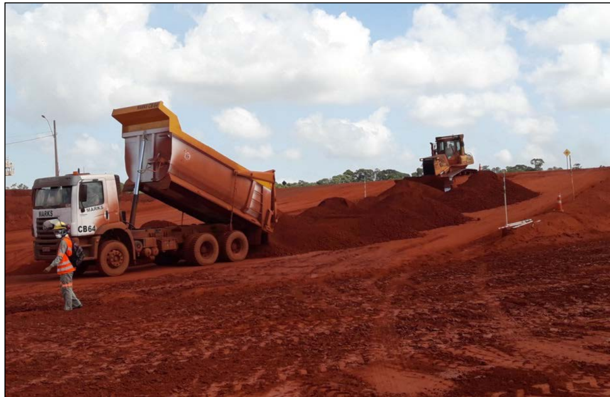
Resíduo filtrado por filtros prensa – baixo teor de umidade
