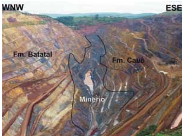
Figura 3 Mina de ferro a céu aberto de Pau Branco da Vallourec Mineração, Quadrilátero Ferrífero. O corpo de minério encontra-se em uma faixa na zona de contato da Formação Cauê com filito da Formação Batatal subjacente que, por sua vez, encontra-se parcialmente mineralizado em ferro (Fonte: Carlos Alberto Rosière).
