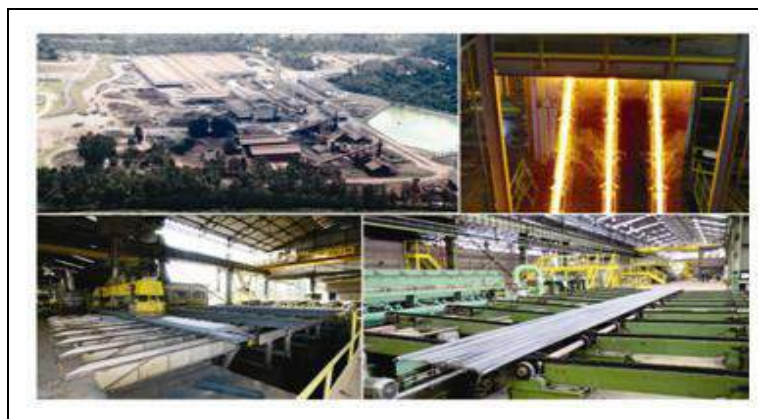
Figura 102. Sinobras – Planta de aços longos.
