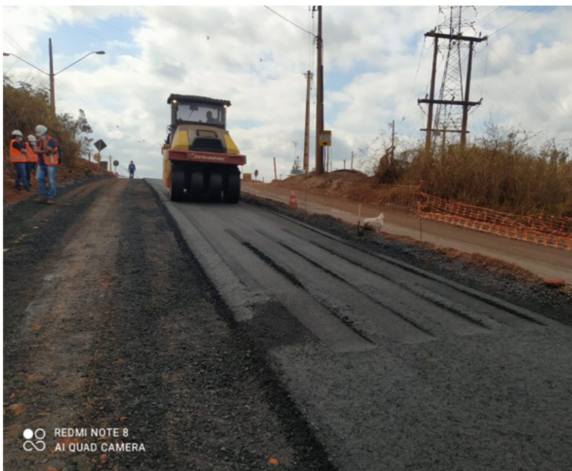
Figura 2: Pista Experimental de Cauê- Fase de execução
