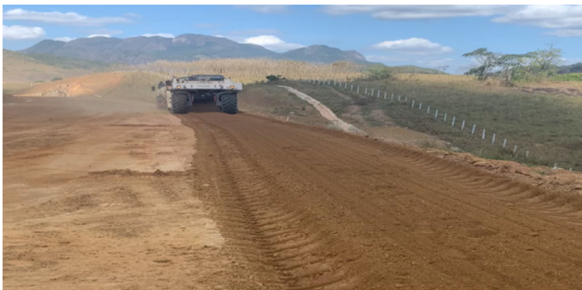
Figura 1: Obra da rodovia Contorno Mestre Álvaro com Areia Vale
