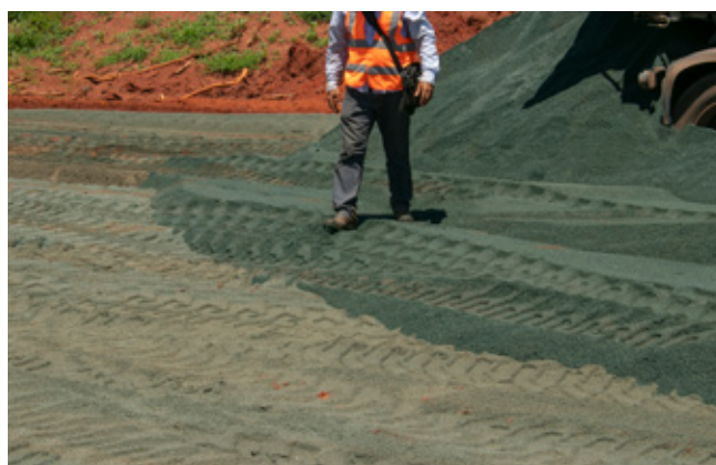
Figura 5: Detalhe da aplicação do coproduto na composição do pavimento asfáltico
