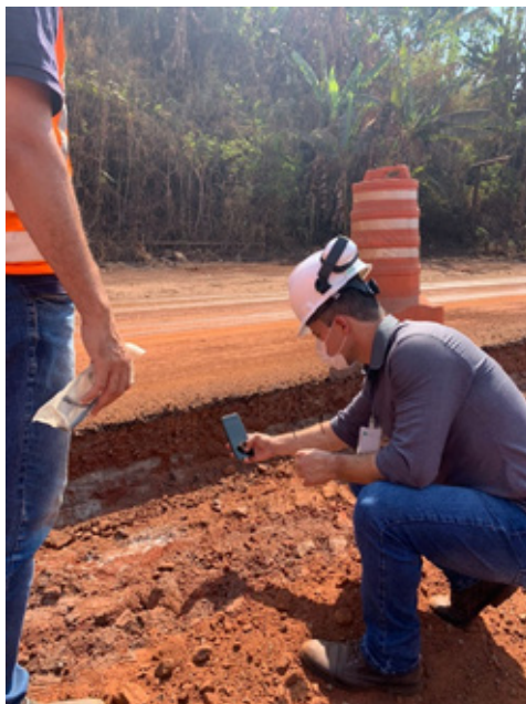
Figura 1: Pista Experimental de Cauê- Fase de execução
