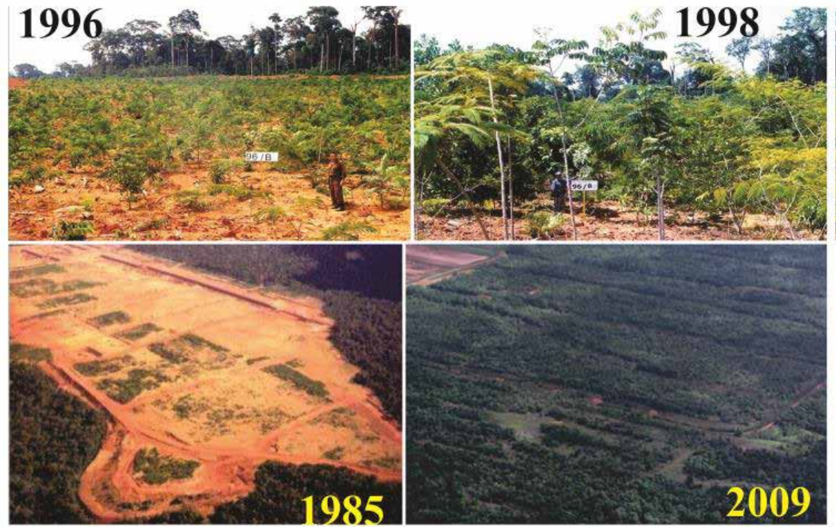
Figura 151 - Exemplo de revegetação na MRN em Trombetas Fonte: MRN
