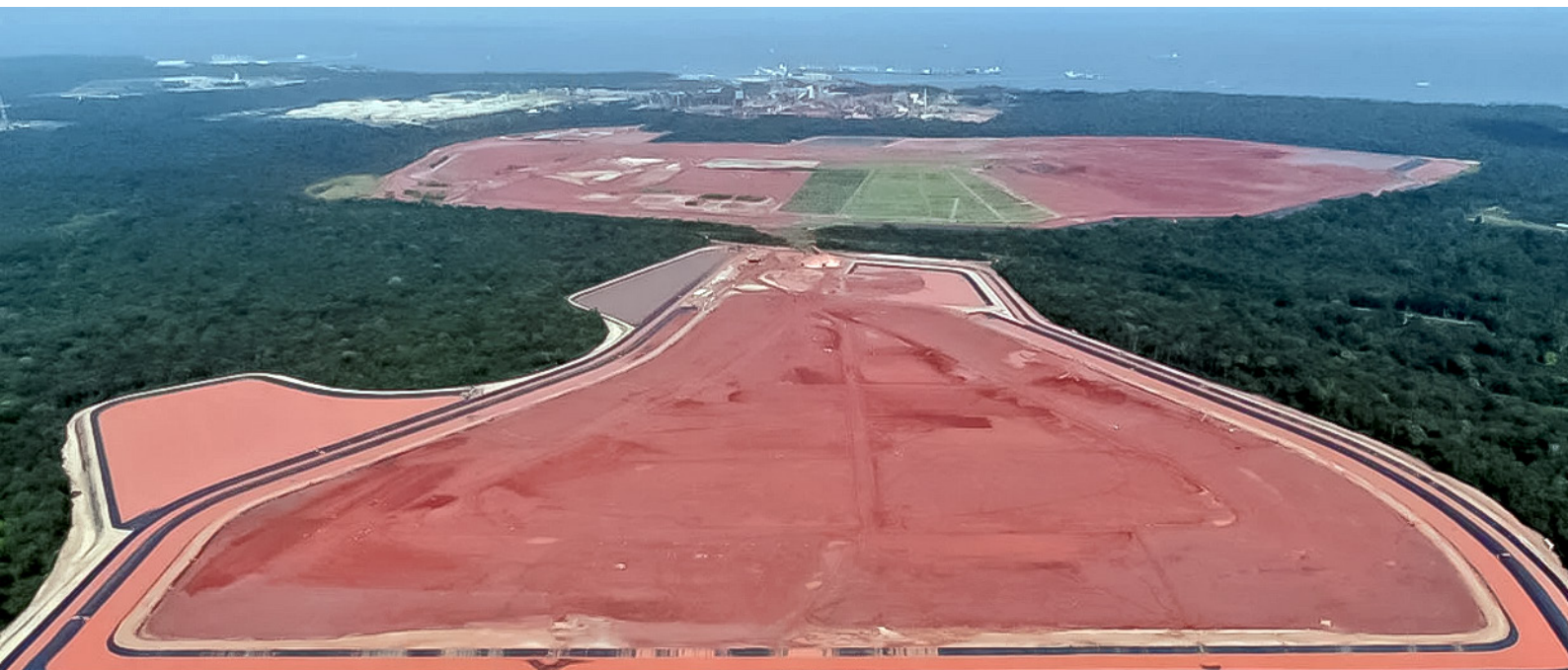
Figura 67: Empilhamento filtrado. Fonte: Hydro, 2023.
