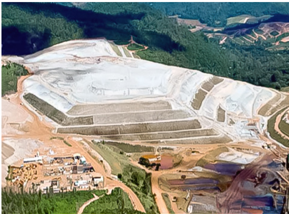
Figura 66: Empilhamento drenado. Fonte: IBRAM, 2016.
