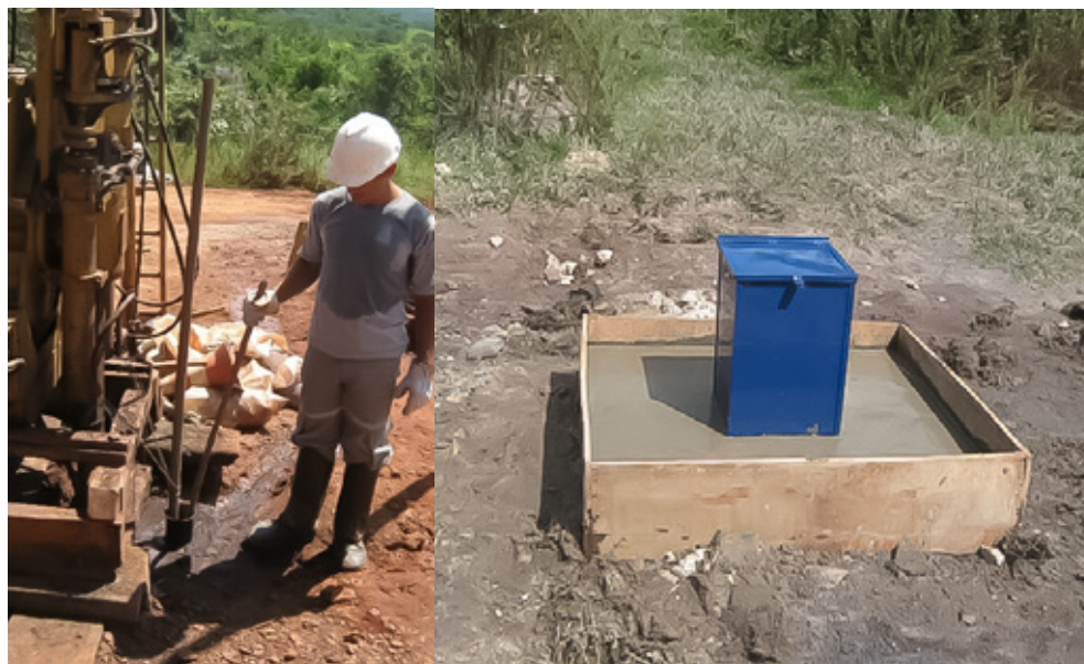
Figura 25: Construção de um piezômetro.
