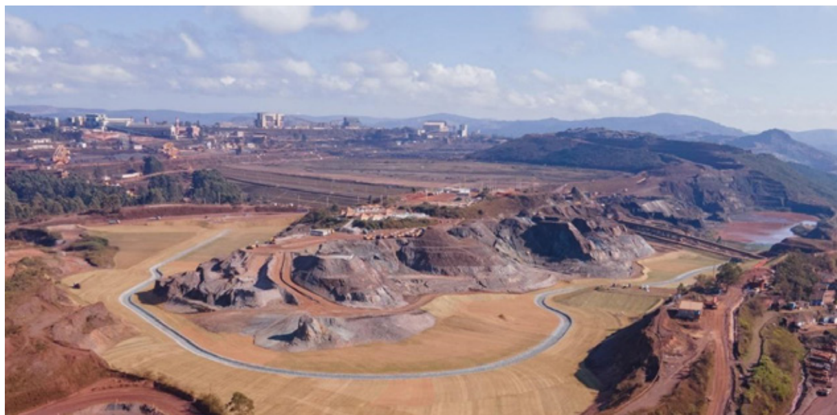
Figura 61: Barragem Fernandinho – Mina Mar Azul – Nova Lima MG, após descaracterização. Foto: Cortesia Vale S.A.
