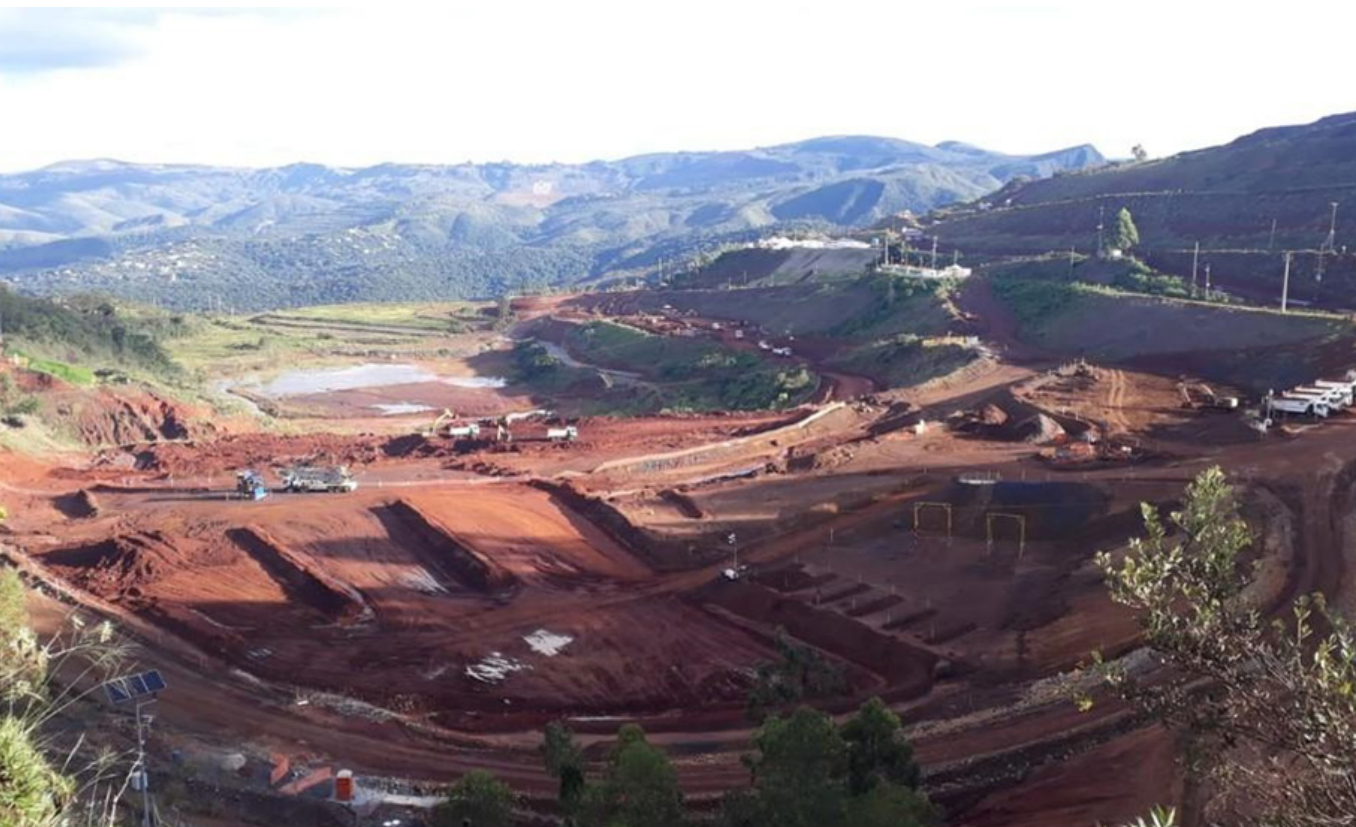
Figura 62: Descomissionamento da Barragem B3/B4 , Mina Mar Azul, em Nova Lima – MG , com equipamentos autônomos. Foto: Jornal O Globo.
